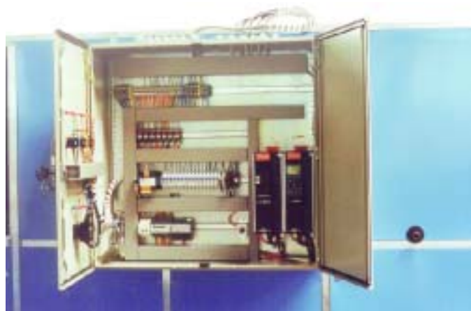
Шкаф управления, смонтированный на вентиляционной установке.
